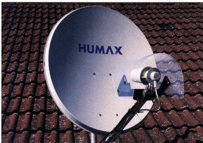
Bild 1: Sende-Empfangs-Antenne für QO-100; zum zusätzlichen Schutz des Duoband-Erregers wurde ein handelsüblicher LNB-Wetterschutz montiert.
